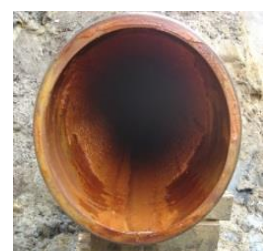
Reinigung einer verockerten Rohwasserleitung mit dem Comprex®-Verfahren Quelle: Hammann
