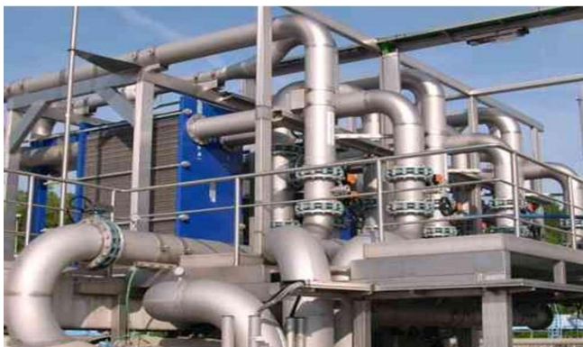
Kühlsystem mit Plattenwärmeübertrager und hydraulische Kennlinie vor sowie nach der Reinigung
