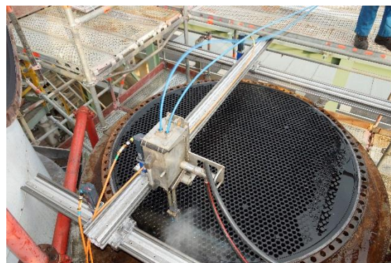
Robotized Lance Frame auf einem Wärmetauscher
