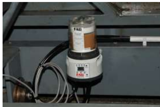
Montierter FAG CONCEPT8 am Fuß des Lüfterfundaments.
