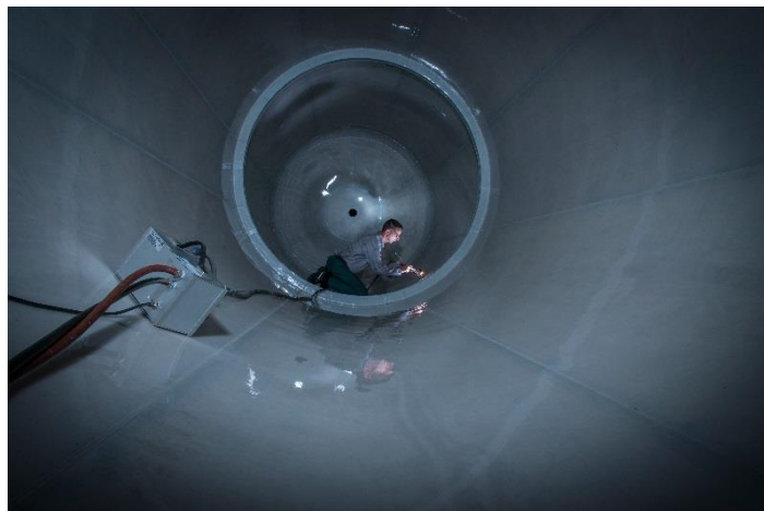
TECTRION-Mitarbeiter verschweißt ECTFE-Platten Quelle: TECTRION
