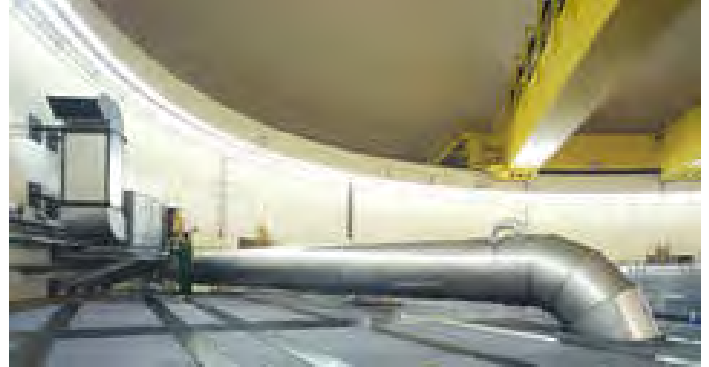
Instandhaltung im Kraftwerk, Quelle: Kraftanlagen München
