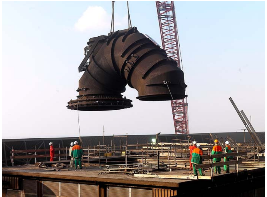
Montage einer Umlenkung im Stahlwerk Tat Steel Ijmuiden, Niederlande, Quelle: Oschatz GmbH
